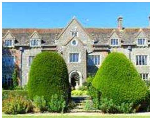
Ecclesden Manor (built c. 1630)
