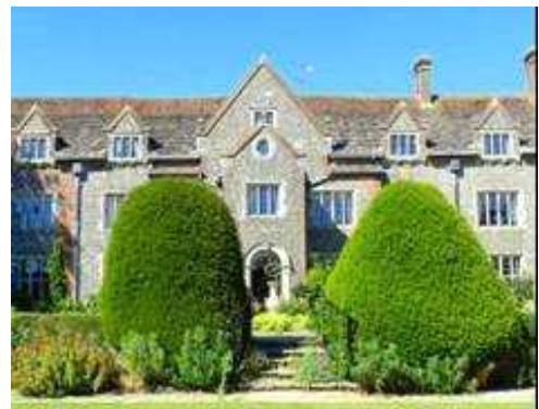
Ecclesden Manor (built c. 1630)
